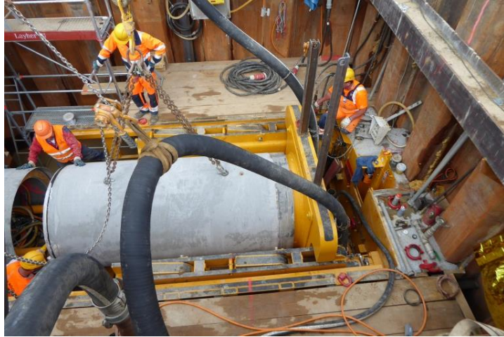
Neubau Regenwassersystem (Vortrieb) Startbahn West
